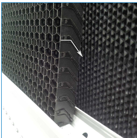
Orientamento dello schermo d'ingresso combinato
