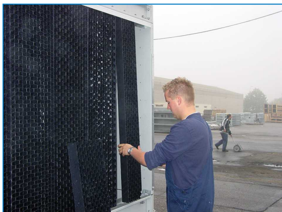
Rimuovere gli schermi d'ingresso combinati
