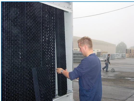
Rimuovere gli schermi d'ingresso combinati.
