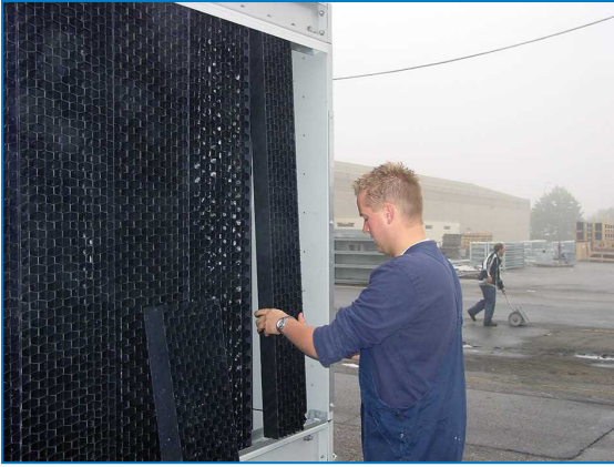
Retire los filtros de acción múltiple
