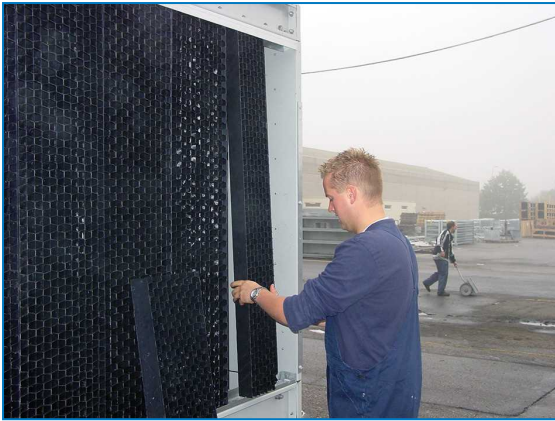
Démontage des déflecteurs d'entrée d'air
