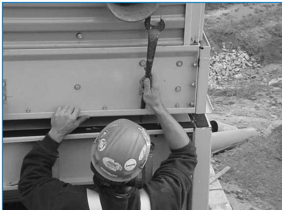
Allineamento dell'angolo con spina di assemblaggio
