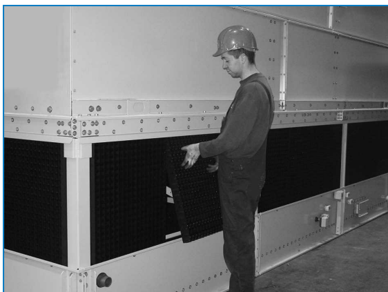
Снятие комбинированных щитов на входе
