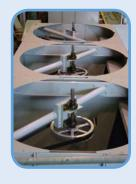
Motor individual y transmisión conjunta con cada ventilador con un panel de partición plenum que permita la operación independiente en cada ventilador para el control fácil de la capacidad
