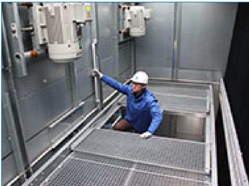
Кроме легкого доступа изнутри к верхним частям изделия, установка внутренней платформы также означает более легкие и безопасные осмотр и обслуживание в соответствии с директивами ЕС по безопасности. Хотите дополнить вашу градирню этой опцией для более легких и безопасных осмотров? Для получения дополнительной информации свяжитесь с [местным представительством BAC](#).
