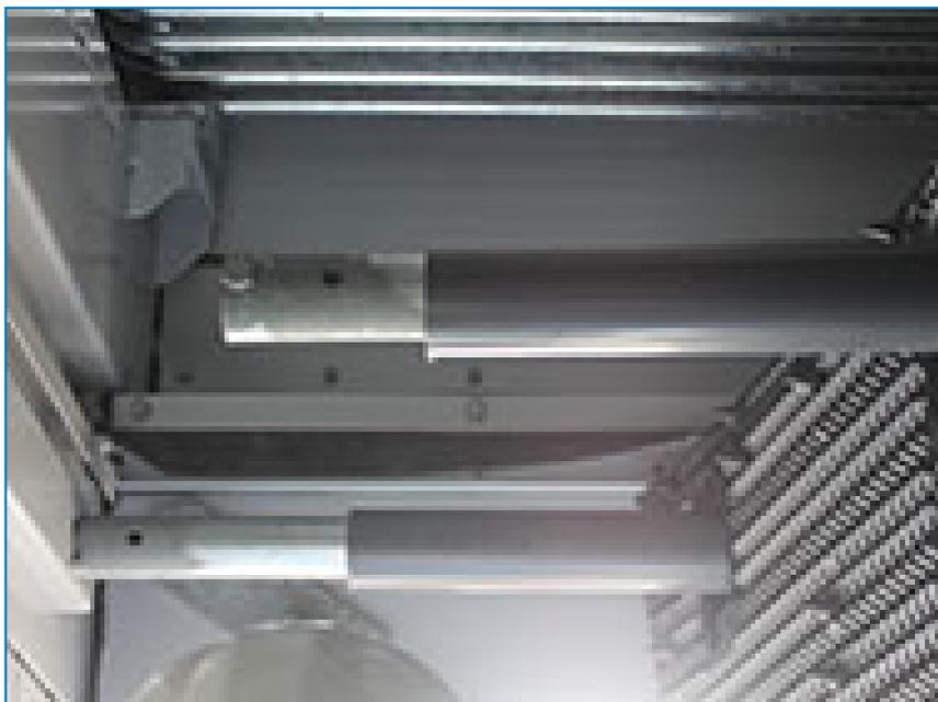
L'uso di travi di supporto telescopico per il pacco di scambio facilita la rimozione e la sostituzione dei fogli del pacco di scambio.
