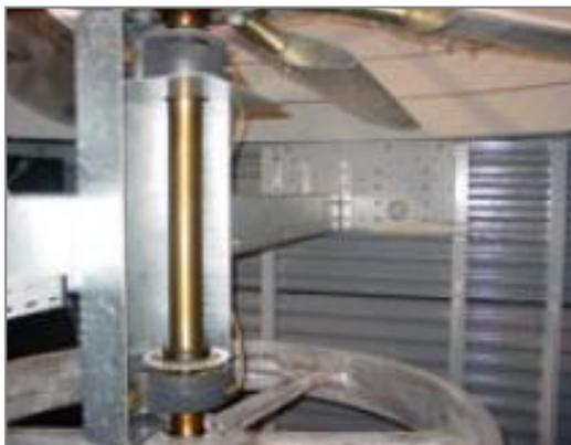
Verlängerte Schmierleitungen mit problemlos zugänglichen Schmiernippeln können **zur Schmierung** der Lüfterlager verwendet werden.
