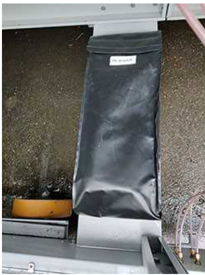
Locatie van afdekking aan de onderzijde
