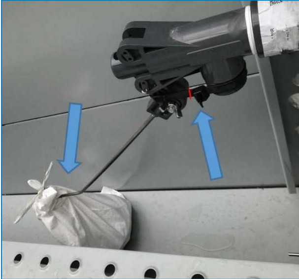
Bevestiging en inwikkeling van de vlotterbal
