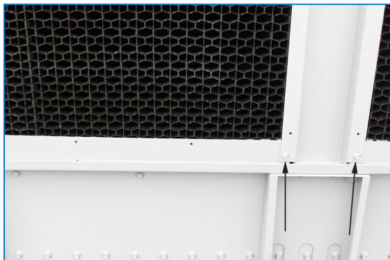
Transportbeugels verwijderen
