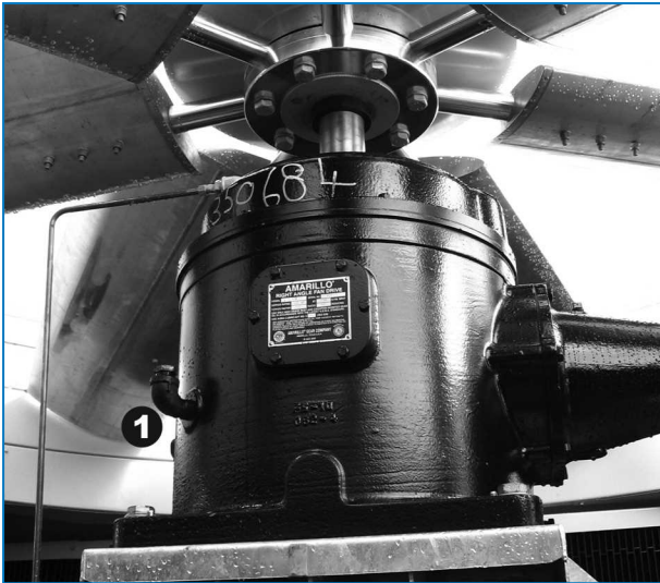
Tandwielaandrijving met enkelvoudige overbrenging
