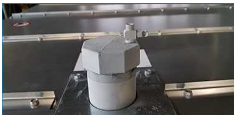
Raccord de batterie fileté sur stockage thermique de glace
