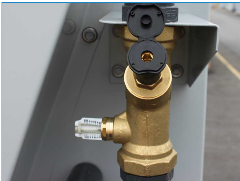
Tornillo de ajuste del caudal
