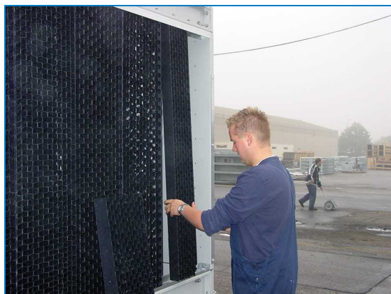
Usuwanie zespolonych osłon wlotowych
