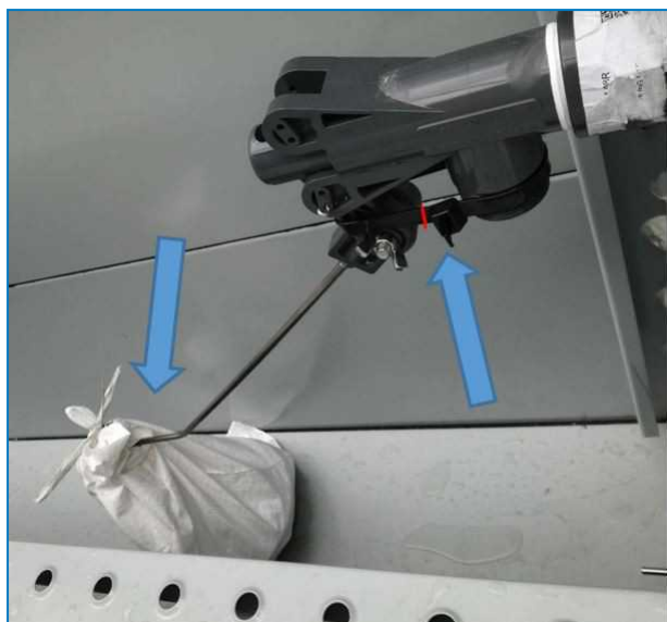
Montaż i owijanie kuli pływaka
