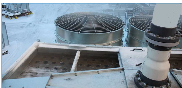
Misa wody gorącej i opcjonalne pokrywy misy rozprowadzającej
