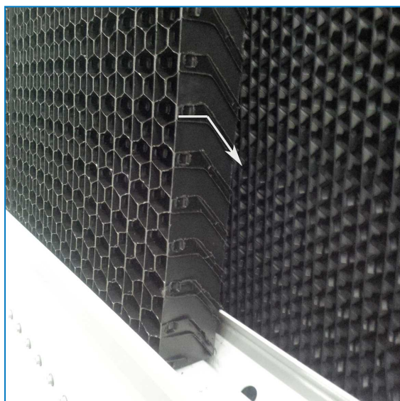
Orientacja zespolonej osłony wylotowej
