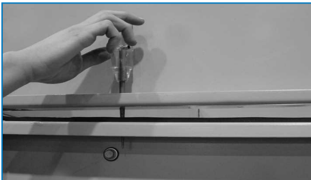
Verwendung des Treibdorns zur Ausrichtung der Schraublöcher
