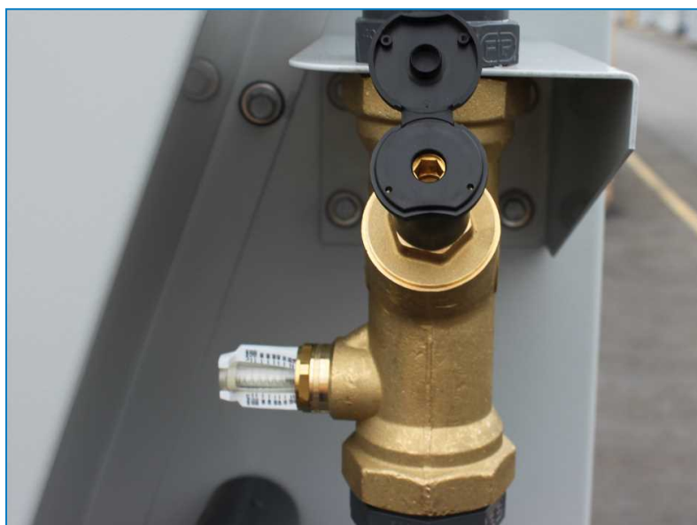
Šroub pro nastavování průtoku vody
