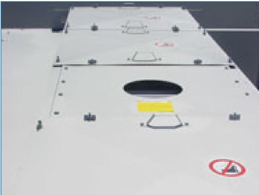
Wasserverteilwannenabdeckungen auf Geräten **verhindern die Verunreinigung des Beckenwassers durch** Fremdkörper usw.
